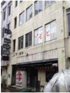
借り上げ当時のニシワキビル
