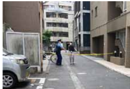
タイルが落下した直後の現場
